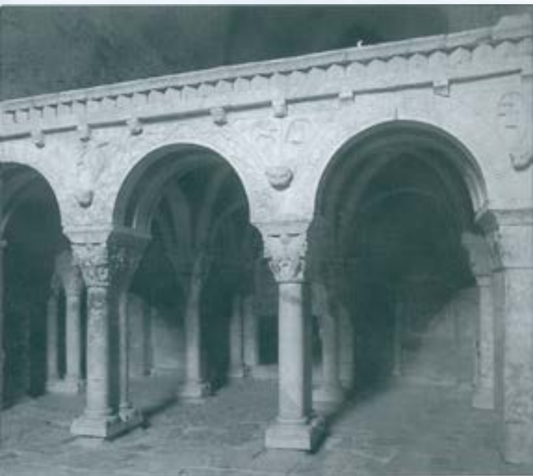
Serrabona. Façana oest de la tribuna.
