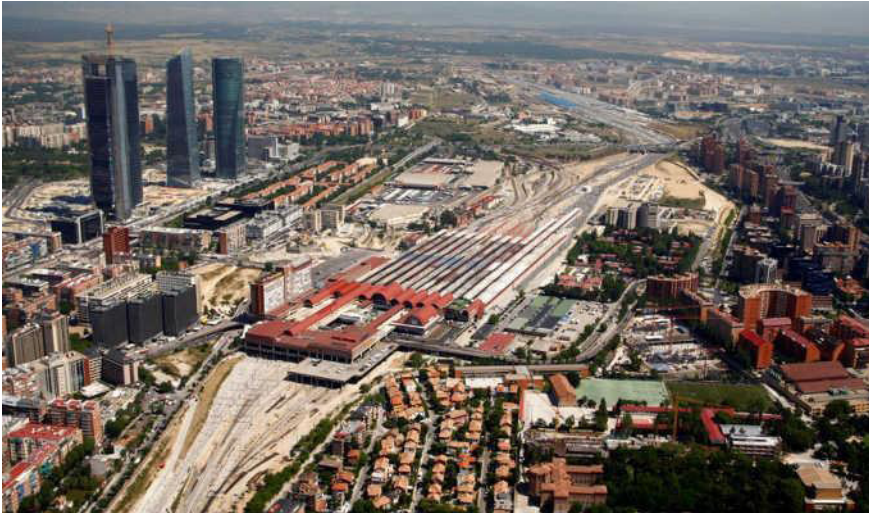
Madrid Nuevo Norte imagen de la situación actual.
