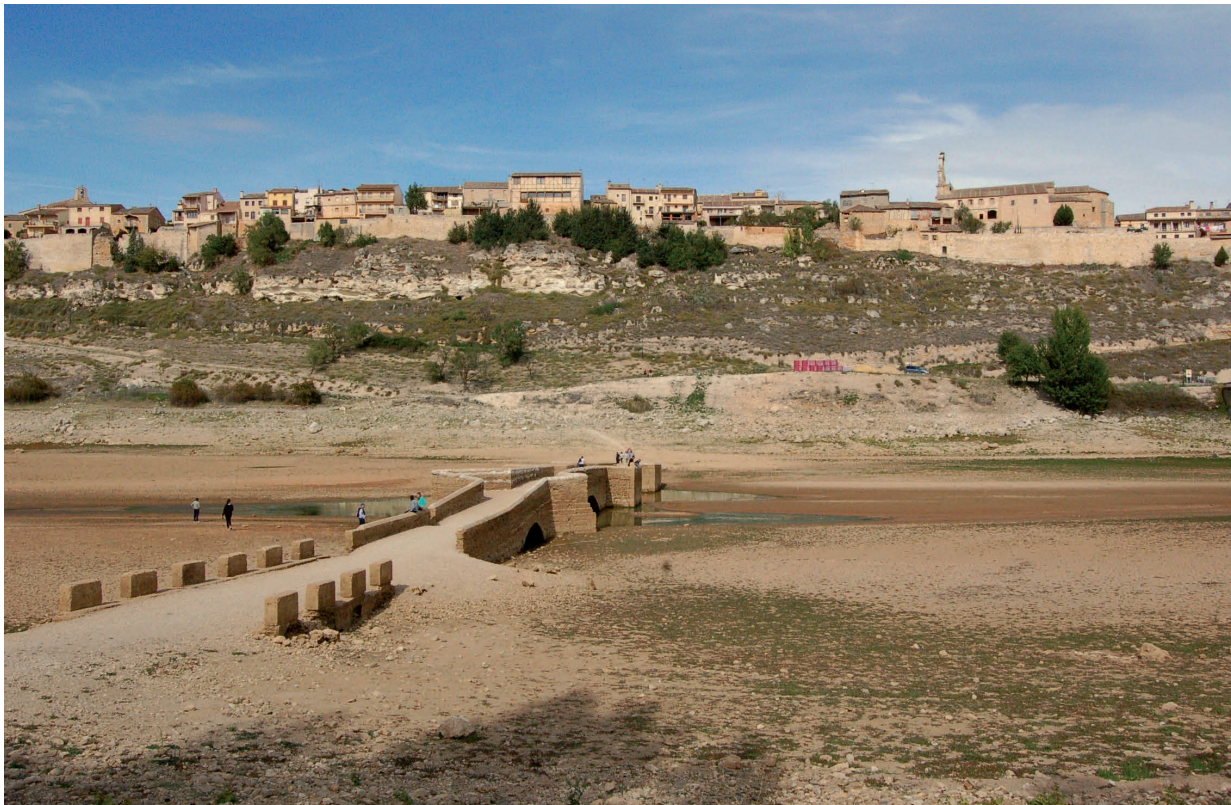
Fig. 1. Panorámica de Maderuelo y el puente sobre el Rianza una vez que descendieran las aguas por causa de la sequía de 2017
