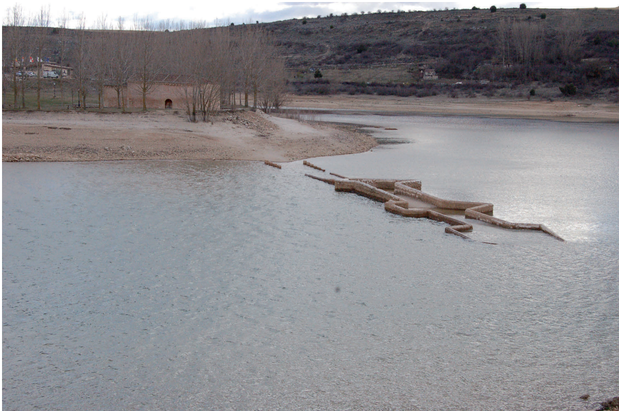
Fig. 2. Situación del Puente Viejo de Maderuelo y la ermita de Santa Cruz, parroquia de un arrabal extramuros. Imagen del invierno de 2018, cuando el embalse comenzó a llenarse y sepultó de nuevo el puente bajo las aguas.
