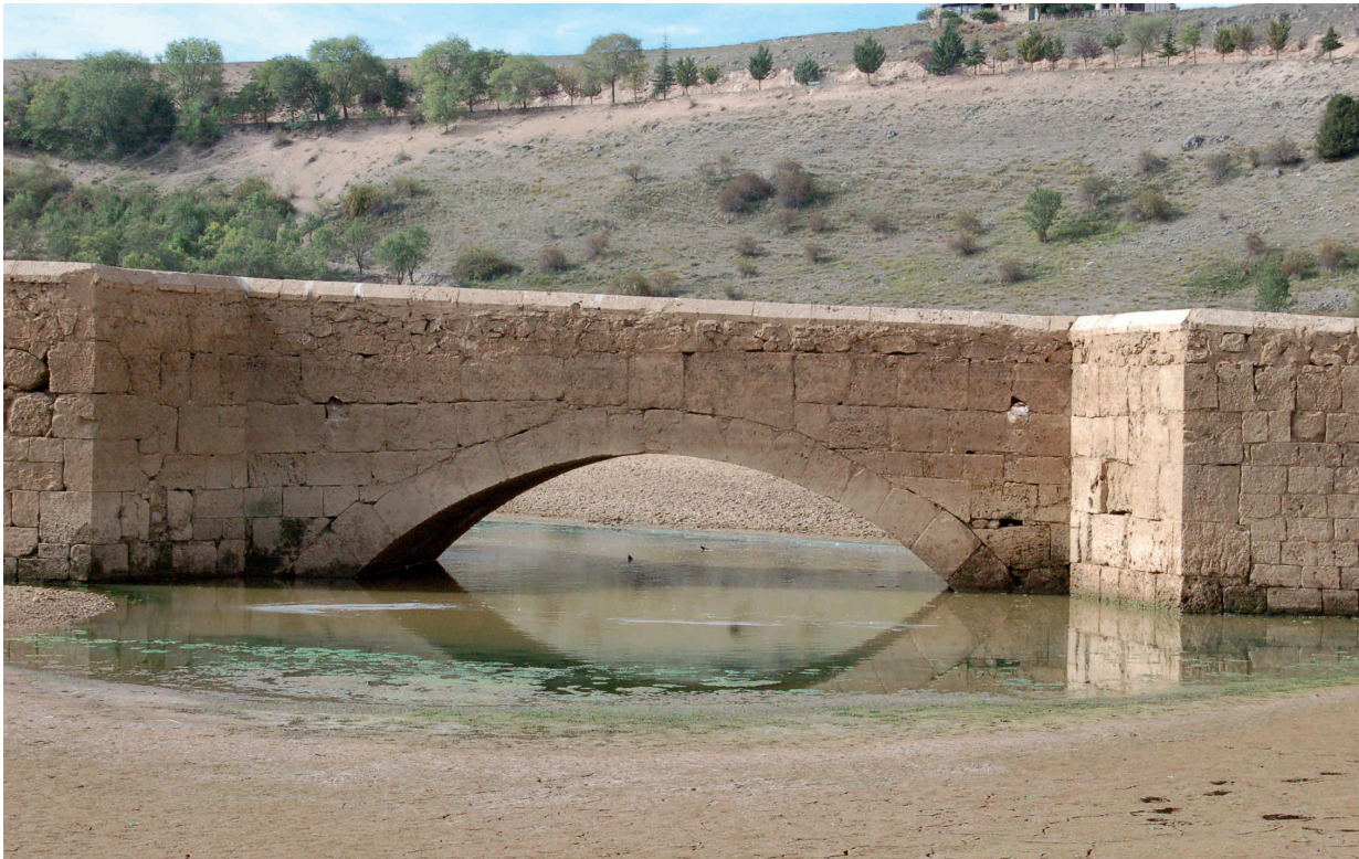
Fig. 5. Segundo arco del puente de Maderuelo. La robustez de la sillería es una característica de las fábricas del siglo XVIII.
