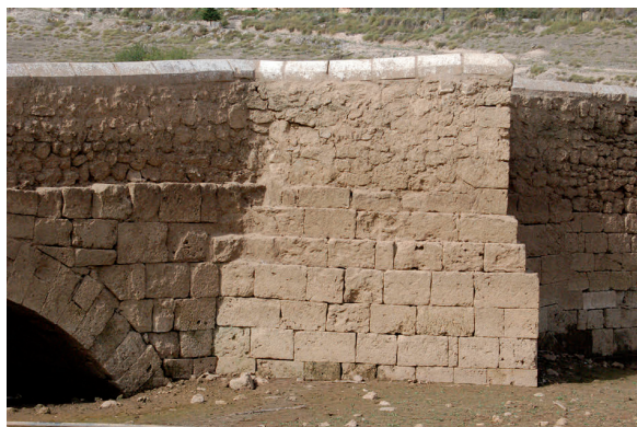
Fig. 6. Espolón de la tercera pila, y cuarto arco del puente de Maderuelo.
