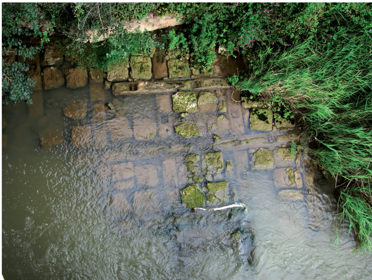
Fig. 5. Zampeado de la parte norte del puente de San Martín Rubiales, con el característico enrejado de madera relleno con piedra.
