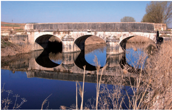
Fig. 6. Vista del frente meridional, aguas arriba, del puente Zofraga sobre el Río Zapardiel en Rueda, Valladolid.
