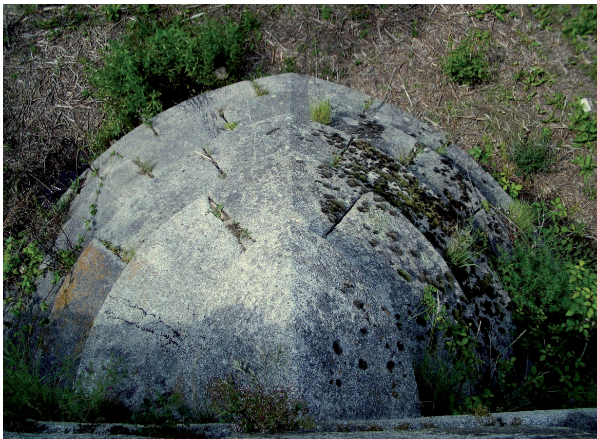
Fig. 3. Tajamar del Puente Almarza o Puente Viejo sobre el Voltoya, en el Camino Real de Galicia, obra de Marcos de Vierna.
