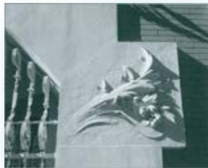
Hotel Suís. Detall. Tècnica de degradat del relleu, també emprada a les tombes dels Gorina Pujol. Obrat per Rossend Prat.
