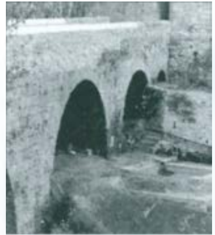
Vista del pont de can Pèlachs un cop efectuada la intervenció de restauració, any 2003.
