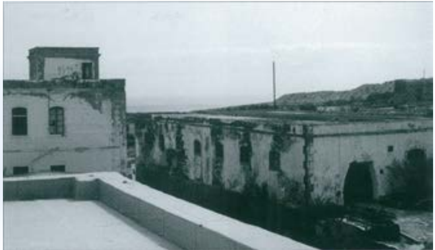
Des de la terrassa del barracot B, on hi dormien catalans, es veu a l'esquerra el barracot A i a la dreta els tallers on treballaven fusters, electricistes i llauers. A baix a l'esquerra l'extrem de l'esplanada de recomptes, arengues i tortures al "pal".
