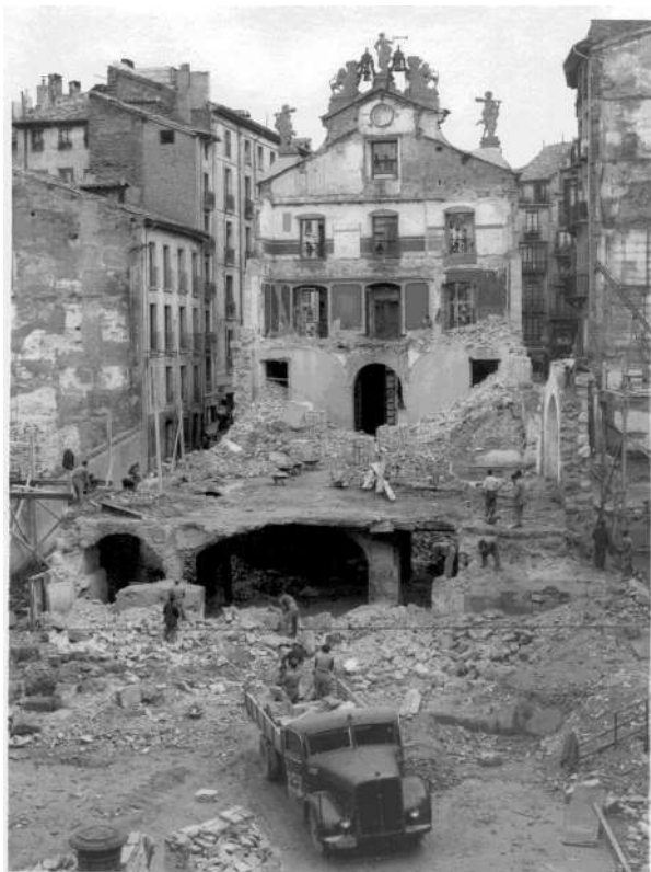
10. Obras de reforma de la Casa Consistorial. 1952 (AMP / J. Cía)
