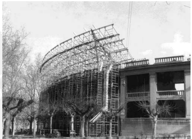
27. Obras de ampliación de la plaza de toros. 1967 (AMP / a.d.)
