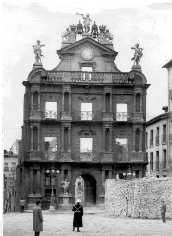
11. Obras de reforma de la Casa Consistorial. 1952 (AMP / J. Cía)
