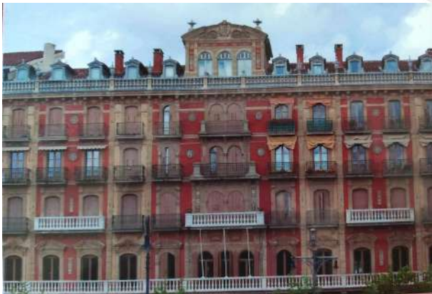
Fachada del edificio del actual Casino.
