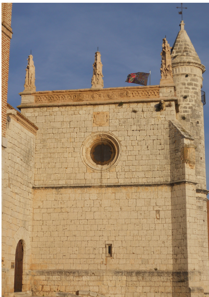
Fig. 3: Muro de la capilla de los Alderete. Iglesia de San Antolín en Tordesillas.
