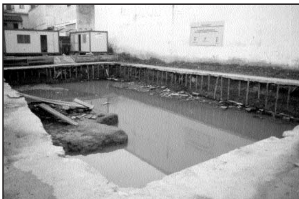
Lámina III: Entibación con perfiles metálicos realizada en Tadeo Murgia (Irún)
