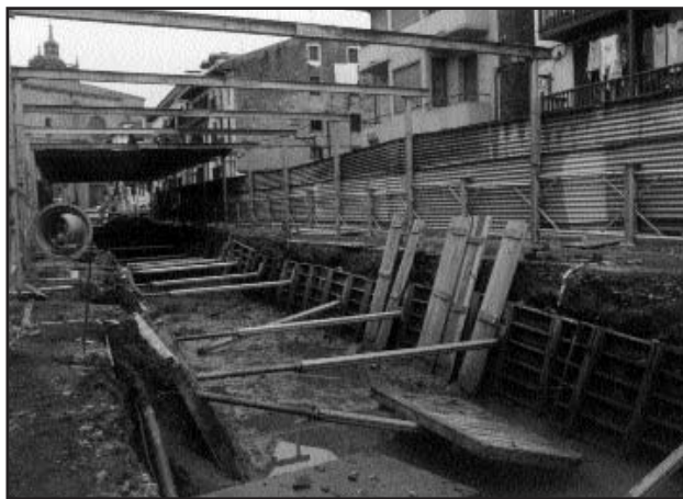
Lámina II: Entibación realizada en la calle Santiago (Irún)
