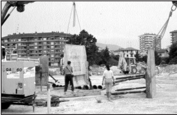
Lámina IV: Intervención arqueológica en Azken Portu: sistema de entibaciones
