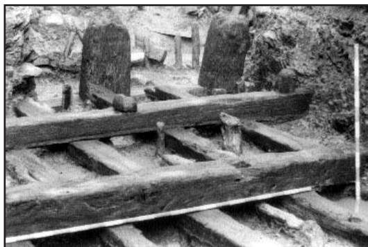
Lámina XIV: Estructura de madera del puerto de la calle Santiago de Irún
