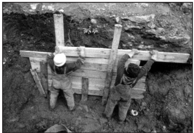
Lámina V: Intervención arqueológica en Panpinot (Hondarribia). Entibaciones
