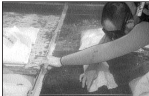
La silicona se aplica manualmente, adaptándola sobre la superficie del objeto con una ligera presión
