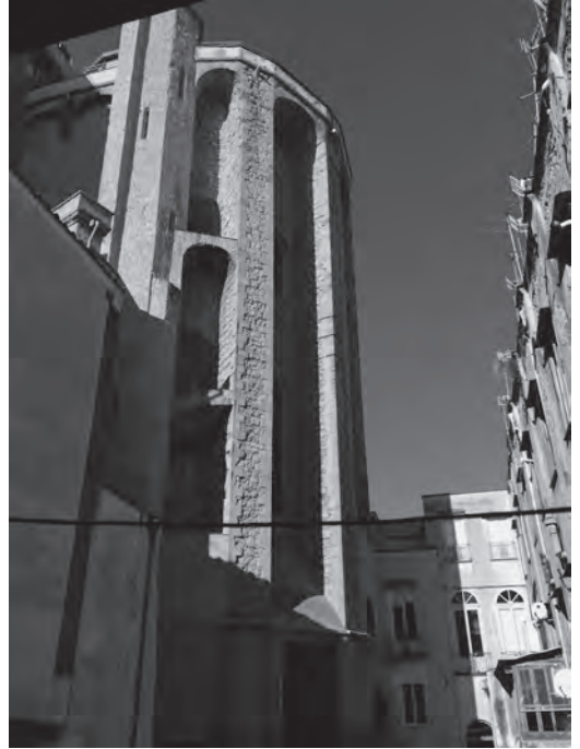
Figura 2 Vista dei contrafforti absidali di restauro (fotografia dell'autrice)
