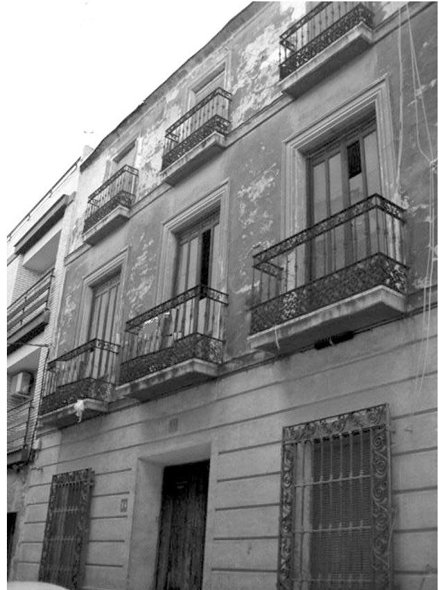
Casa de Peñapareja días antes de su demolición Foto: Manuela Caballero
