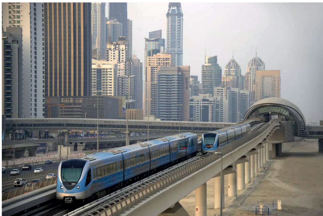
Figura 3. Infraestructura ferroviaria en Dubai. Fuente: Nikkei Asian Review .
