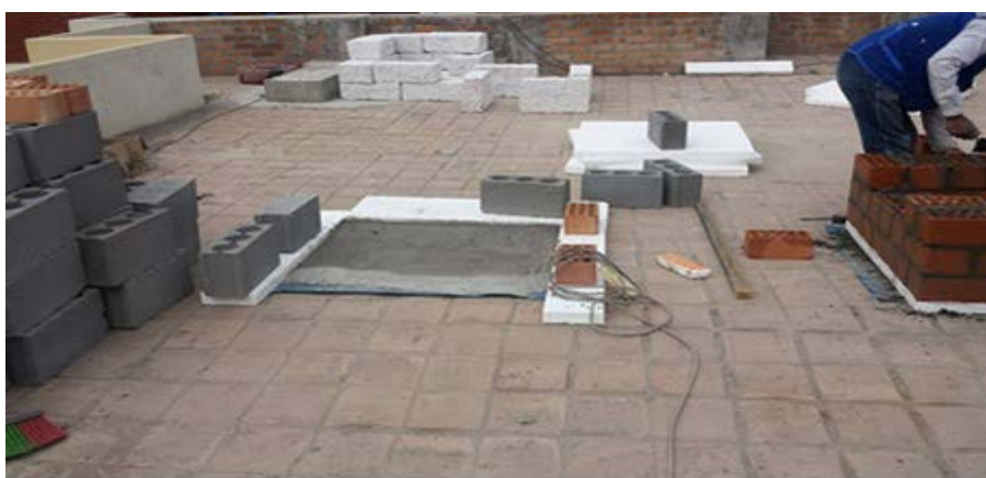
Figura 3. Aislamiento en cubierta de los módulos.
