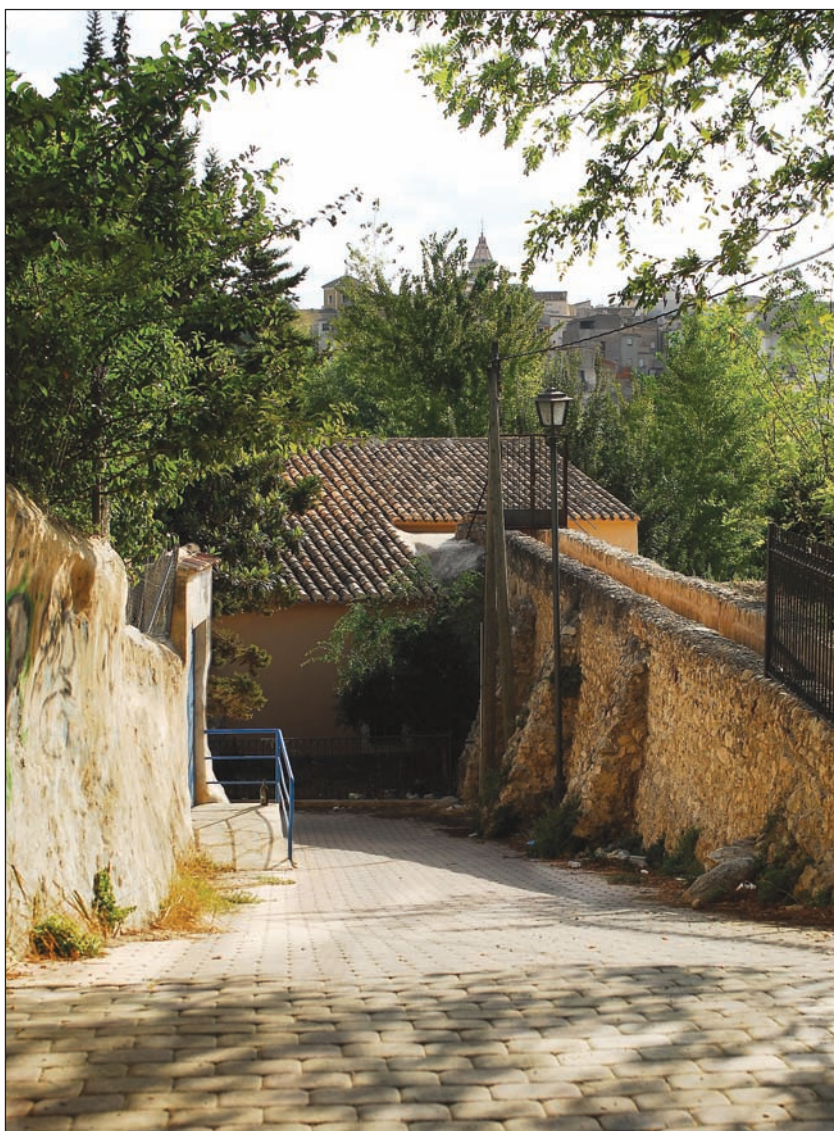
Acueducto que alimentaba el funcionamiento del Molino de Teodoro junto al camino de las Cabras.
