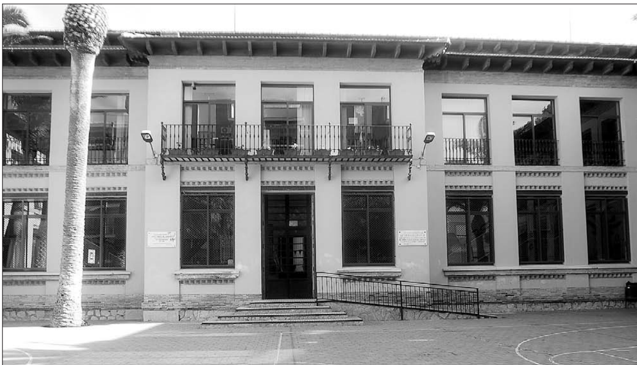
Fachada principal del colegio.
