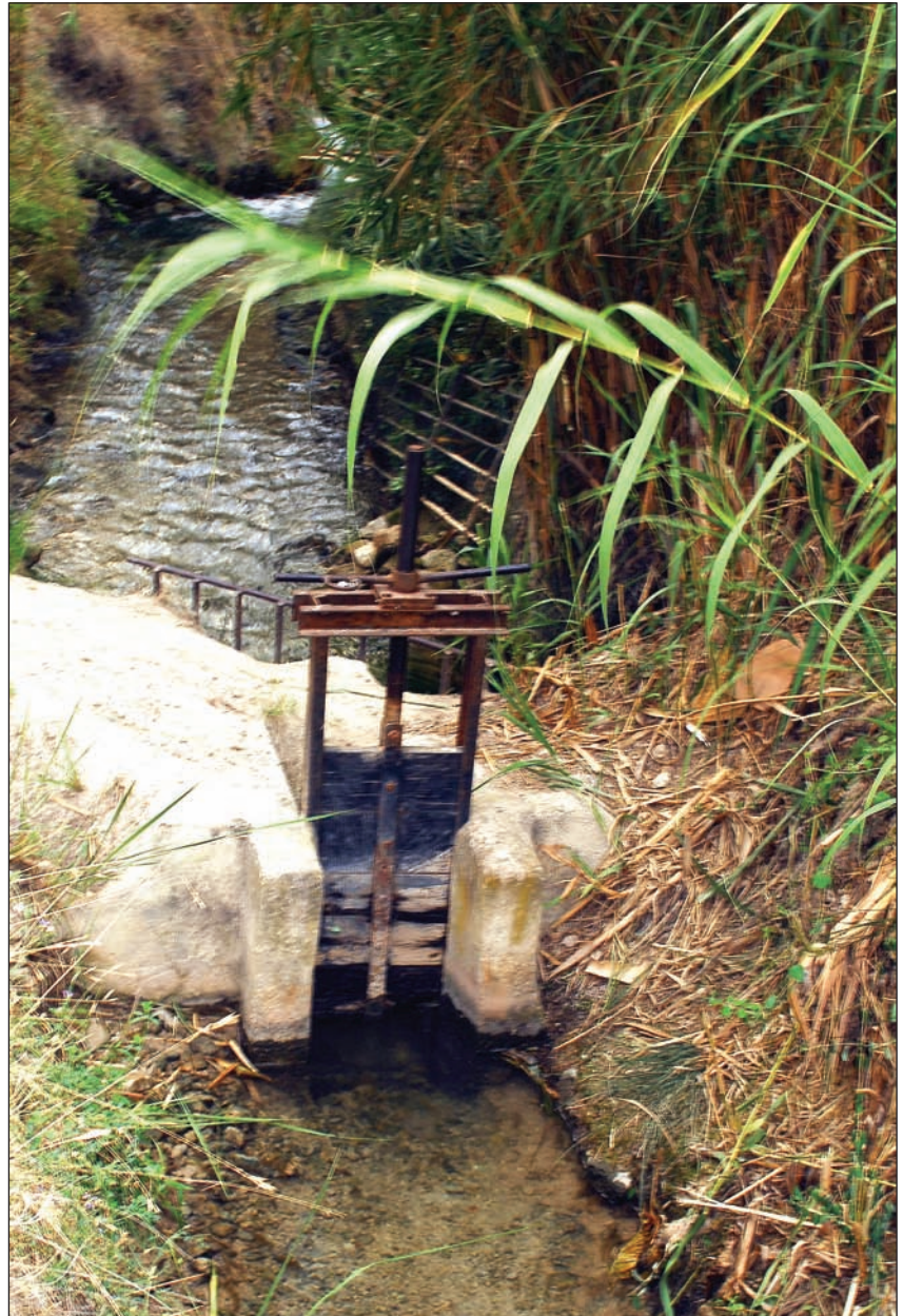
Una compuerta de la acequia de la Andelma.
