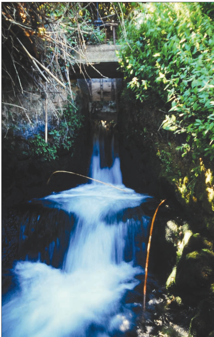
Un salto de agua tras un portón de control de la acequia.
