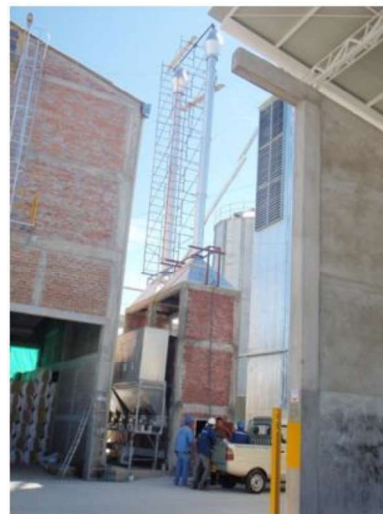
Figura 4. Montaje de las chimeneas de salida de gases. Fuente: Autores.
