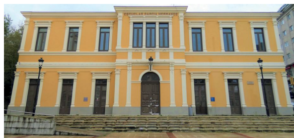
(Fig. 3) Fotografía dos autores (2019): Fachada principal das Escolas García Irmáns (única parte do edificio conservada) .
