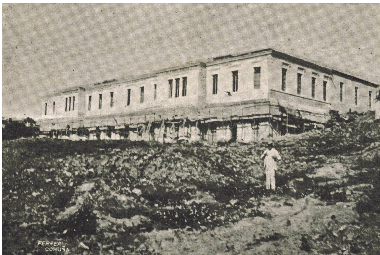
(Fig. 9) Ferrer (1908-1912): Asilo e Escuelas García Irmáns en construcción. Colección privada.
