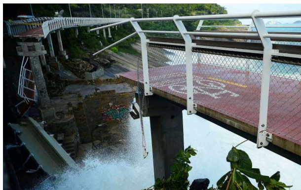
Figura 5: Ciclovía damnificada por las resacas en la orla de Rio de Janeiro en mayo de 2016
