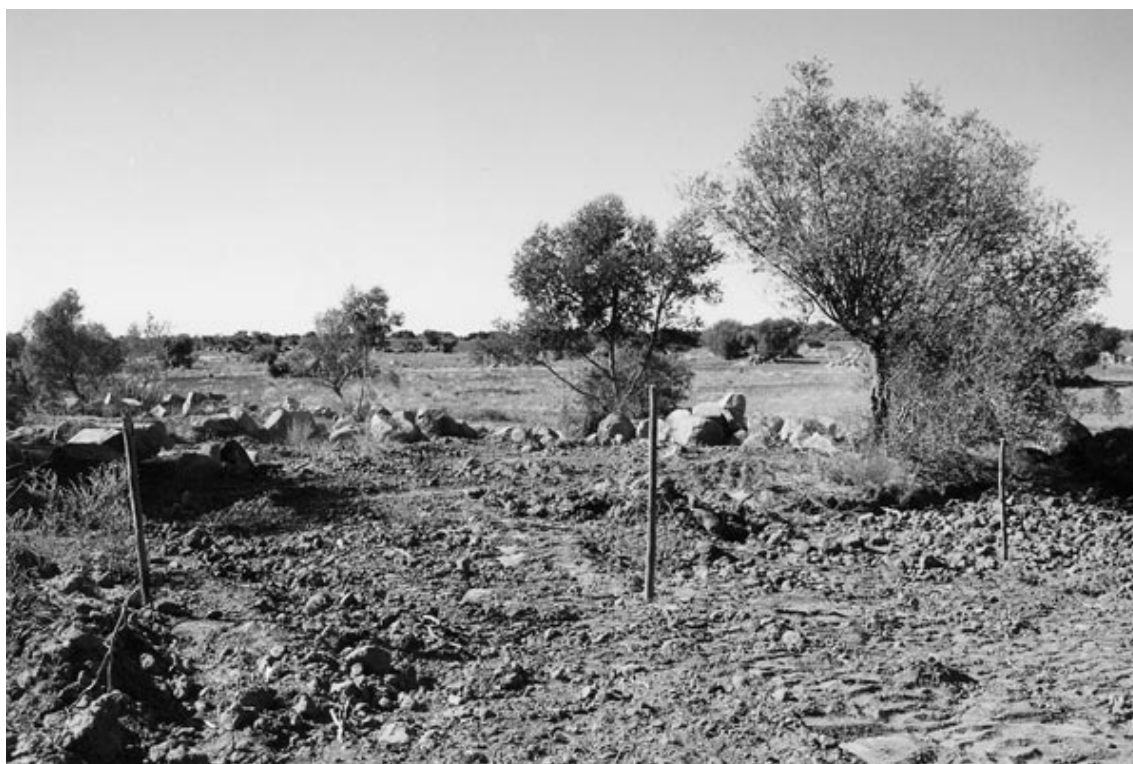
Fig. 39 Aspecto geral do monumento no início da intervenção (foto Susana Pombal).
