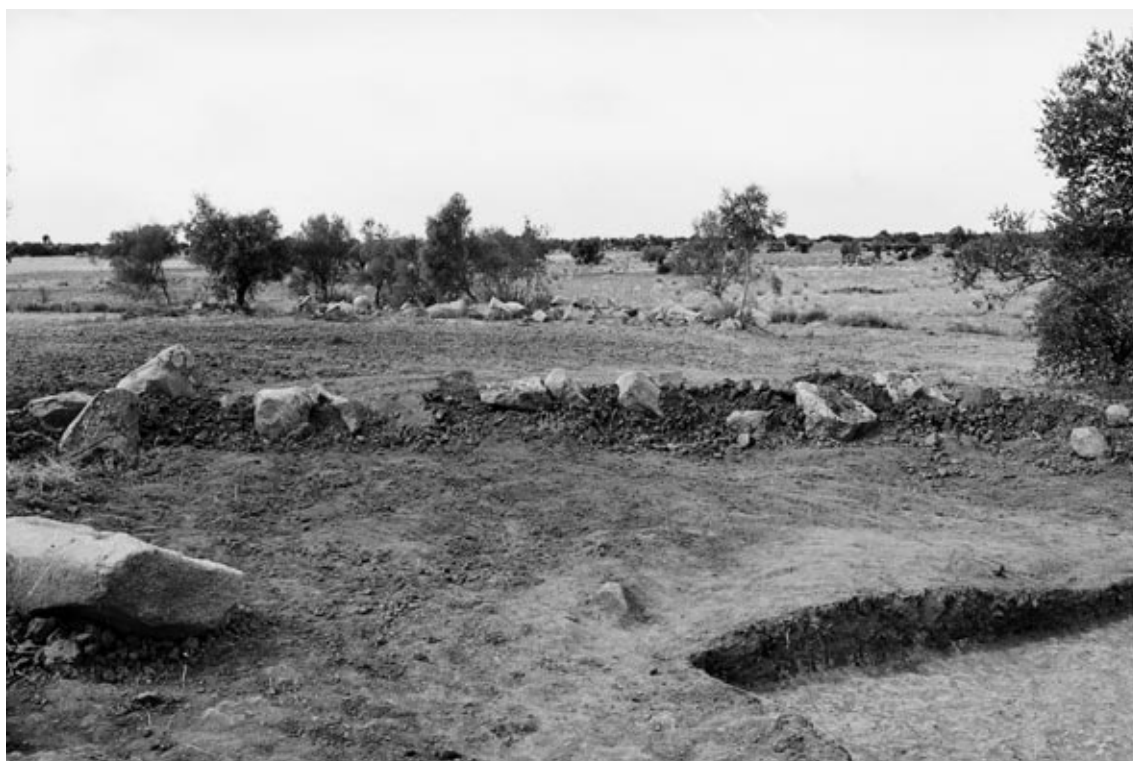
Fig. 8 Muro construído a Oeste para protecção do Monumento, usando terra e pedra das despedregas e onde se projecta plantar vegetação local (giestas e liliáceas de grande porte).
