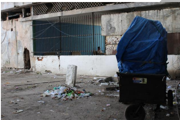
Figura 6. Edificio Holiday , 09 de octubre del 2016, 08h23
