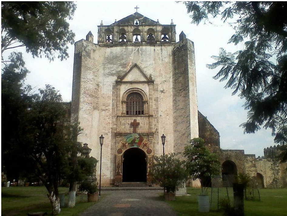
Figura 2. Fachada del exconvento de Tlayacapan, Morelos
