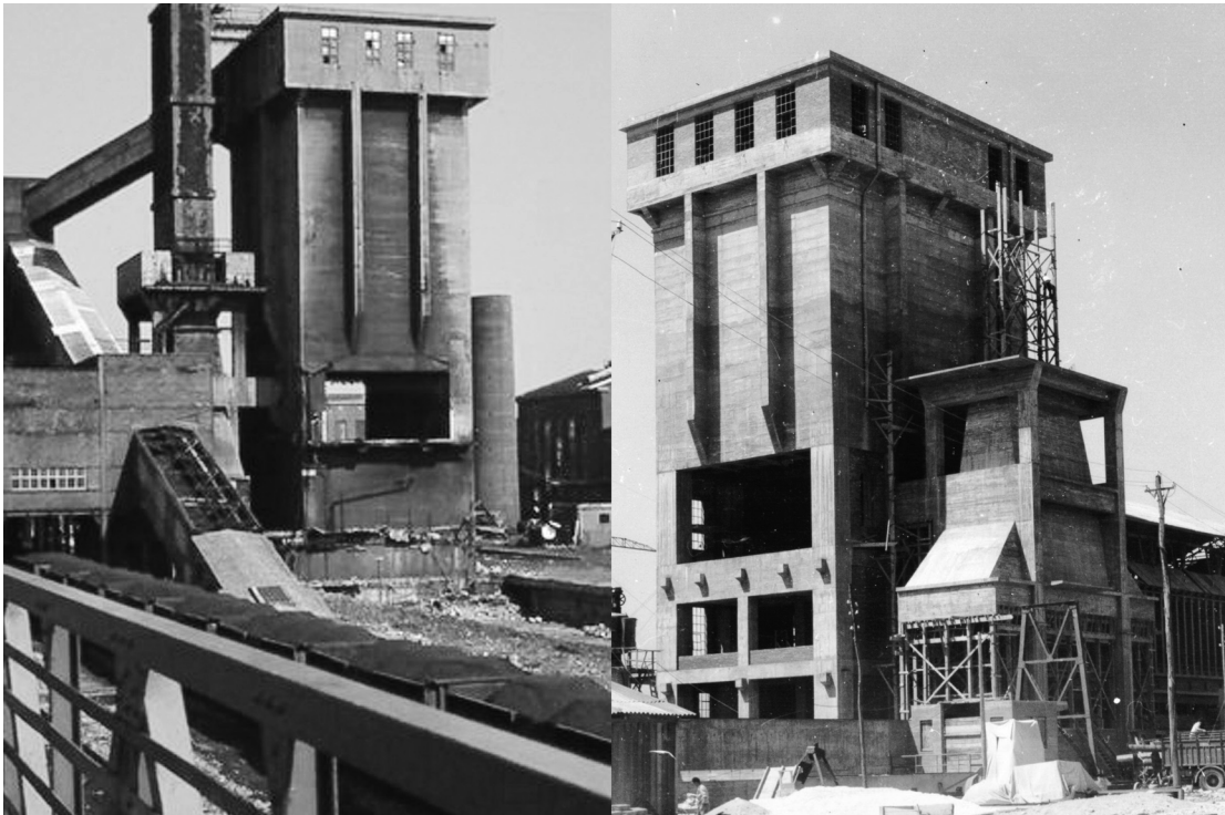
Fig. 3. A la izquierda, torre de carbón de la mina Friedrich Heinrich de Kamp-Lintfort (Alemania) en marzo de 1980 y, a la derecha, torre de carbón de Avilés e inicio de obras para la torre de apagado. Fuentes: K-H Lipp [obtenida de Wikimedia Commons con licencia CC BY-SA] y Adolfo López Armán.
