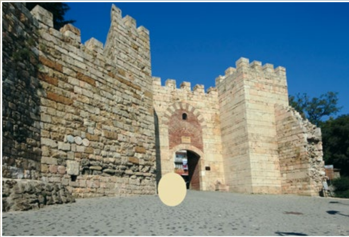
Fig. 20. Puerta de Saltanat Kapisi en Bursa (Turquía). A la izquierda de la elipse se puede ver la obra bizantina con material de acarreo en un soga y tizón muy desordenado, con tambores de columnas incrustados. Se percibe también una pequeña hilada muy deteriorada de sillares de menor altura. Sobre esta obra, y en el resto de la puerta y torre de la derecha, se encuentra la construcción otomana, muy regular, con uso de hiladas de muy poca altura, a veces repitiendo dos, alternadas con otras a unas veces a soga, otras a tizón.
