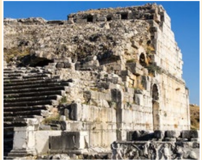
Fig. 68. Teatro de Miletus. En el perfil se ve la colocación de sillares acostados en las hiladas de menor altura.
