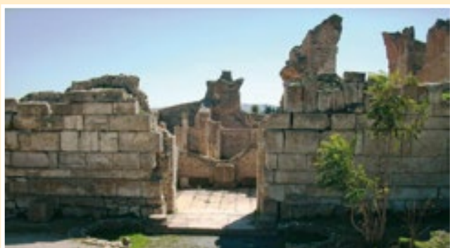
Fig. 49. Makhtar. Cierre amurallado de las grandes termas. Son visibles algunas hiladas de sillares "tumbados". Al pertenecer a una puerta parece haber sido construida con mayor cuidado, y mantener una mayor regularidad.
