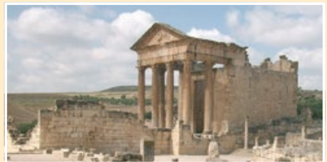
Fig. 44. Dougga. Cierre del capitolio y fórum. Son numerosos los engatillados debido a la discontinuidad y desorden de sus hiladas.
