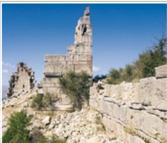
Fig. 83. Torres y muralla en Leontopolis. En este caso, las hiladas de menor altura son menores que las demás vistas.
