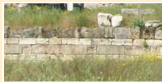
Fig. 90. Base de la misma muralla anterior. Entre hiladas de menor altura, otra con una alternancia de dos sogas por un tizón.
