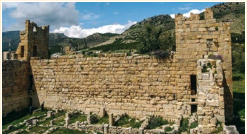
Fig. 55. Interior de Ksar Lemsá. Al igual que ocurre en el exterior, las primeras hiladas están más cuidadas y sobre la hilada de menor altura (en este caso, es la sexta hilada visible, mantenida también en el faldón de la izquierda), la obra se desordena, lo mismo que ocurre en el Lienzo 1 (Plaza de la iglesia).
