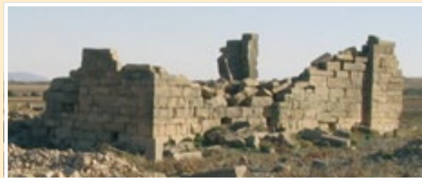
Fig. 50. Aggar, cercana a Dougga. Se aprecia una buena continuidad en sus hiladas, e intercala algunas de acostados.
