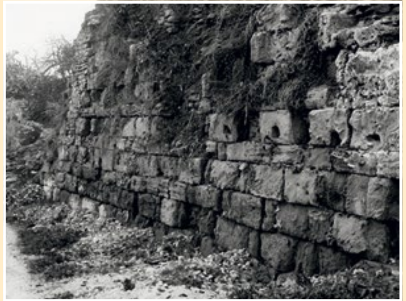
Fig. 14. Imagen del archivo Temboursy de calle Salinas. En la parte baja se aprecian dos hiladas a soga y tizón, y sobre estas la secuencia varía, sucediendo una hilada de acostados con una sola a soga y tizón.
