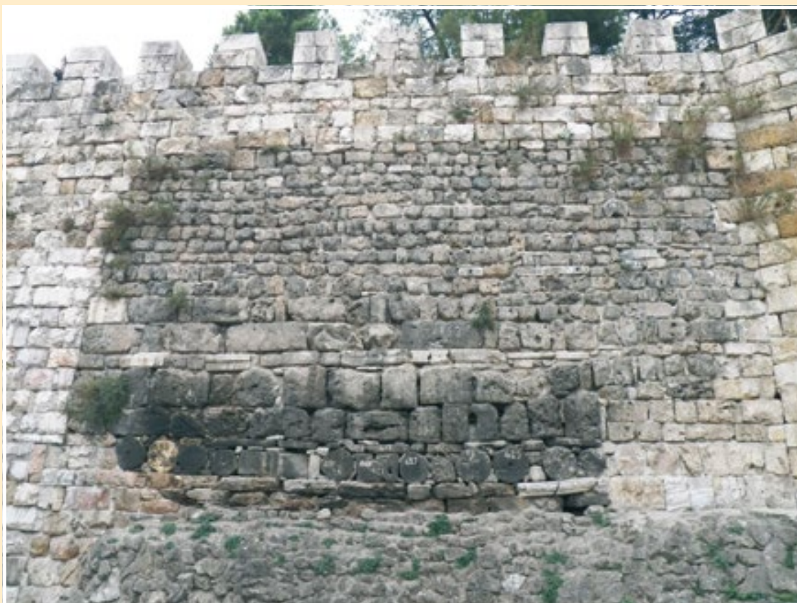
Fig. 22. Lienzo de muralla en Bursa. Se aprecia claramente el acarreo de la obra bizantina enmarcada arriba y abajo por hiladas de sillares de menor altura. Sobre estas alguna hilada de sillares desordenada y obra con sillarejos, para terminar en su parte más alta con la obra otomana. No es una obra bizantina parecida a la nuestra tal y como afirman en el estudio de los paramentos ( Revista U.E. , 0 nº-2, 2015).
