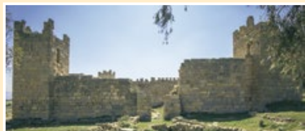
Fig. 53. Puerta lateral en Ksar Lemsá. En la base de la muralla y la torre a la izquierda de la puerta se pueden ver varias hiladas bastante homogéneas a soga y tizón, con una de menor altura encima de ellas. En las partes superiores se desordena un poco la obra. A la derecha de la puerta no existe la hilada de acostados.
