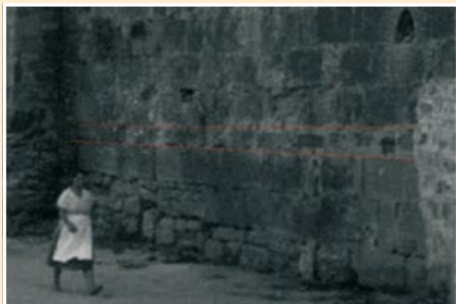
Fig. 3. Imagen del archivo Temboursy donde se puede apreciar la base irregular, las hiladas de sillares a soga y tizón y, encima de estos, la hilada de sillares “acostados”, característicos de época bizantina.
