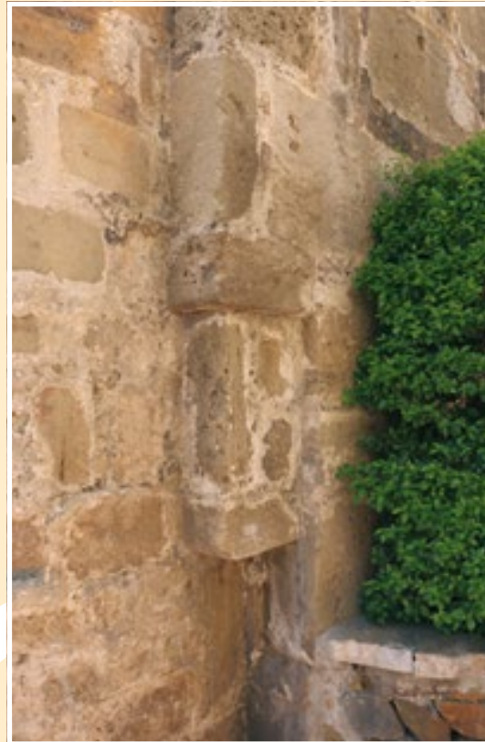
Fig. 6. Esquina noreste de la torre del Cubo donde se aprecia el vuelo que posee la cara este de la torre y el adorno bajo él realizado con sillarejos, y terminación en chaflán redondeado. La torre semicircular pudo ser añadida para cegar una posible puerta en esa fachada de la torre del Cubo.
