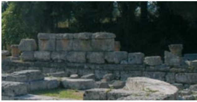
Fig. 92. Olympia. Muro de la Stoa Sur junto al Bouleuterion. Las hiladas superiores construidas con sogas, pero en la hilada inferior se puede ver una alternancia de dos sogas por un tizón.
