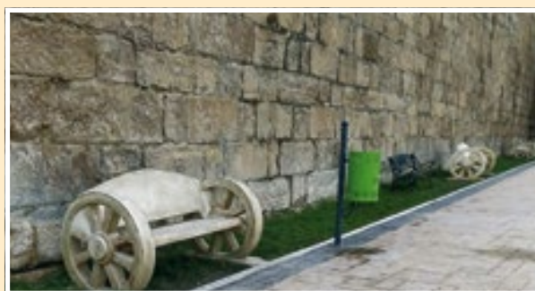
Fig. 40. Otro tramo de la muralla de Tebessa donde es más continua la repetición soga y tizón por hiladas, muy parecida a la que tenemos en el castillo de Marbella.
