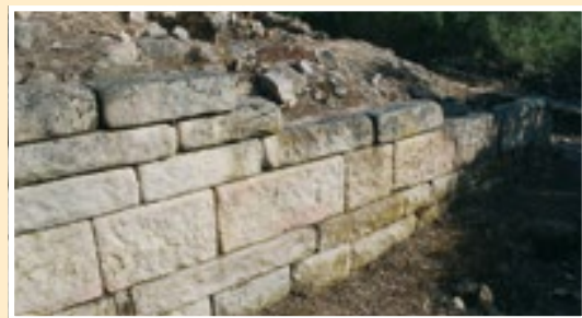
Fig. 91. Estagira. Muro de un templo datado en el siglo V a.C. con predominio de sogas, aunque no todas del mismo tamaño, y repitiendo hasta tres veces las hiladas de sillares acostados.
