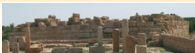
Fig. 63. Sbeitla. Al fondo se puede ver el lateral de uno de los fortines con una hilada de acostados y sobre y bajo ella hiladas con predominio de la sogá.
