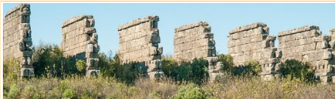
Fig. 97. Aspendos. Salas del mercado en el lado oeste del ágora. Igual fábrica que la del Bouleuterion de Alabanda, pero en este caso triple hilada con alternancia a soga y tizón sobre la de sillares acostados.
