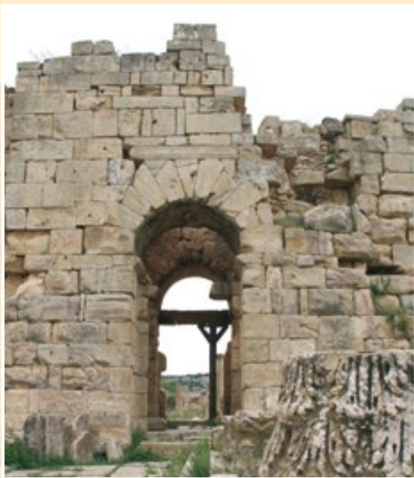
Fig. 43. Madaure. Vista de la puerta desde el interior del recinto. Claro ejemplo, sobre todo en la parte alta, de la obra bizantina desordenada y de acarreo.
