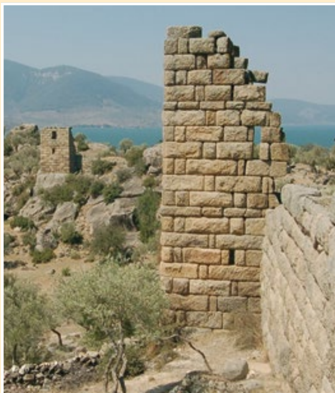
Fig. 85. Torres en Heraclea del Latmos. Con predominio del soga y tizón y dos hiladas de sillares de menor altura.
