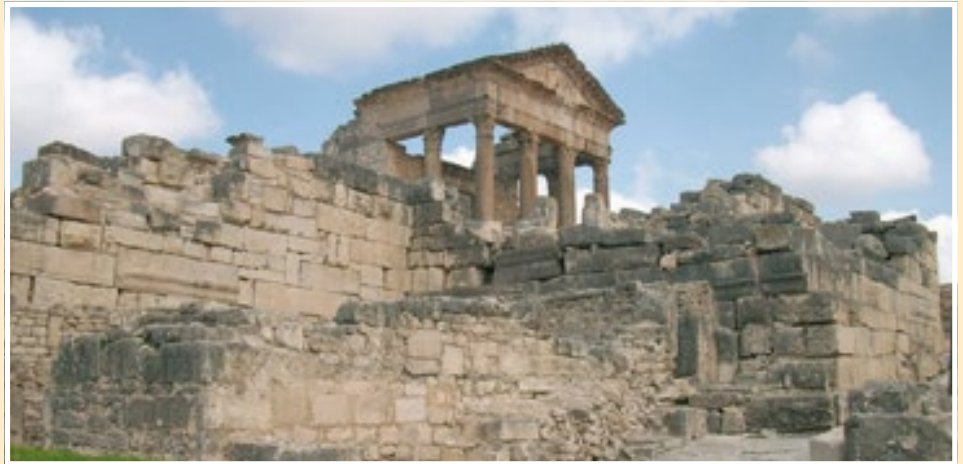
Fig. 100. En segundo plano, esquina de las murallas bizantinas de Dougga construidas con material reutilizado de época romana y claro ejemplo de la obra “Tetris”, muy distinta de la del castillo de Marbella.
