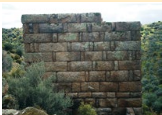
Fig. 81. Torre en Alabanda. Con finos tizones en la mayoría de las hiladas. En las torres, generalmente las hiladas de menor altura marcan los distintos niveles del suelo de las plantas del interior.
