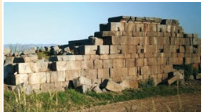
Fig. 75. Lateral del Bouleuterion de Alabanda. Aparejo algo más irregular en la alternancia soga y tizón que los vistos anteriormente, aunque perfecta en la altura de las hiladas y muy parecida a la secuencia de sillares del castillo.
