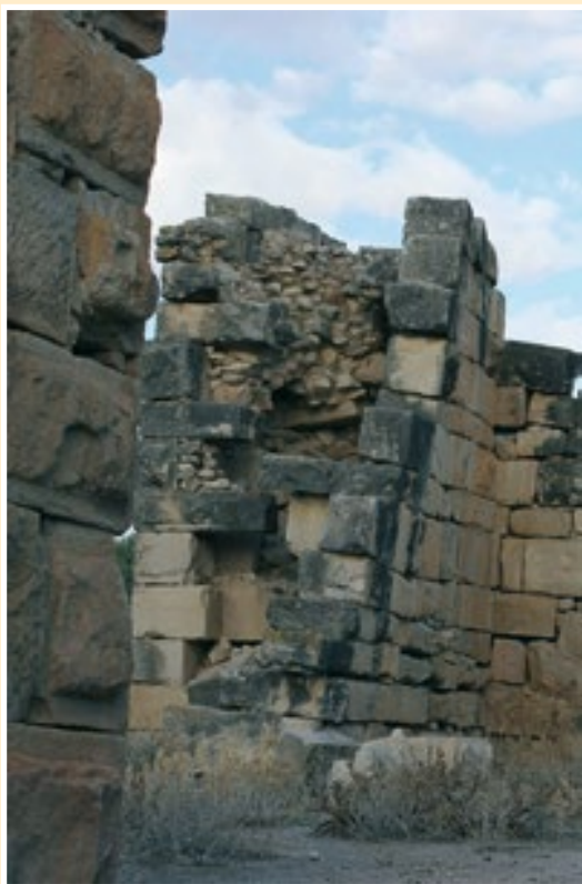
Fig. 61. Ain Tounga. A la izquierda, esquina realizada con sillares almohadillados. En el centro, detalle del emplecton del interior de la muralla y cómo los tizones e incluso sillares acostados penetran en el conglomerado haciendo de tirantas.
