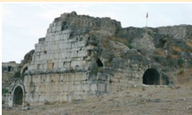
Fig. 67. Teatro de Miletus. Aunque con predominio de la repetición de sogas, se ve la alternancia de una hilada a sogá y tizón, con hiladas de acostados. Puede ser un caso en el que la obra romana usara este aparejo en la ampliación del antiguo teatro griego. En la parte superior derecha se pueden ver los sillarejos que forman parte de la fortaleza bizantina Palation.
