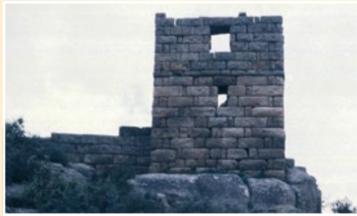
Fig. 87. Base irregular de una torre con engatillado. Heraclea del Latmos.
