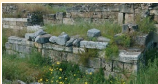
Fig. 89. Base de una torre del cierre del Santuario en Eleusis datada entre el 479 al 461 a.C. Contiene dos hiladas a soga y tizón con otra sobre estas con sillares de menor altura.
