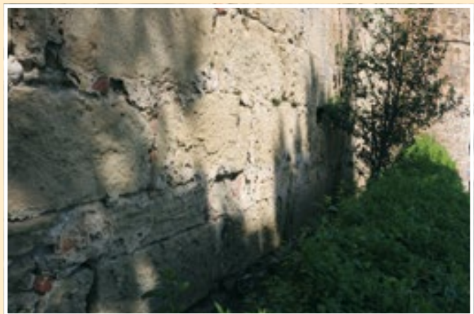
Fig. 17. Hilada de acostados en calle Arte en la intersección con la torre del cubo. De equivocada adscripción romana en el estudio de los paramentos.
