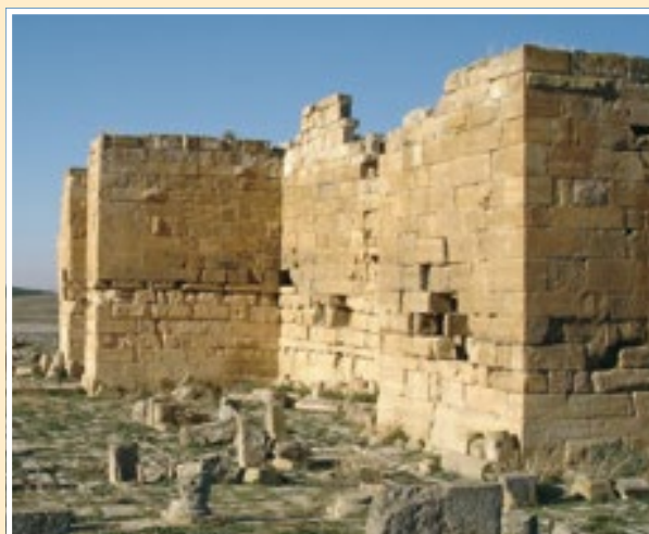
Fig. 41. Madaure. Las primeras hiladas parecen originales romanas. En la parte central de la foto se ven algunos ortostatos y sobre ellos una hilada muy fina de sillares. Las hiladas de menor altura también son visibles en las dos torres. Y en las partes altas algunos sillares almohadillados reaprovechados.
