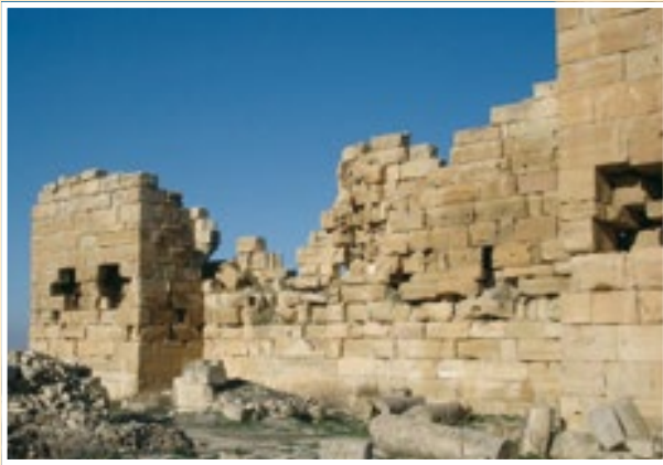
Fig. 42. Madaure. El otro tramo del frontal de la fortaleza. Igualmente que en el anterior se ve alguna hilada de menor altura y sillares almohadillados en su parte superior.
