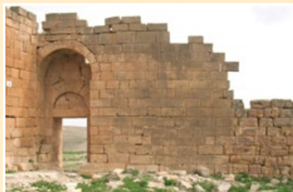
Fig. 51. Haidra. Vista desde el interior de la puerta que se abre al río con el mismo nombre. Pese a existir algún engatillado entre hiladas, es una obra más ordenada. La obra más cercana a la puerta puede ser de construcción romana. No contiene hiladas de acostados.
