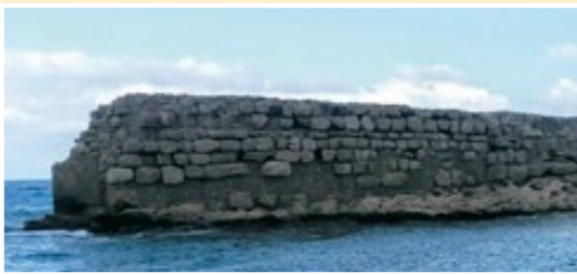
Fig. 93. Rompeolas en Ampurias de construcción focea, siglo VI a. C. con una hilada de sillares de menor altura (la tercera desde arriba).
