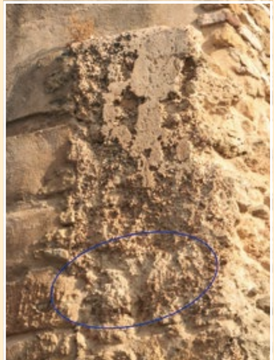
Fig.8. Franja más blanquecina en su parte inferior, posiblemente se corresponde a la impronta dejada por el nivel de suelo de la torre.
