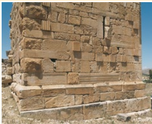
Fig. 62. Ain Tounga. Clara utilización de material de acarreo romano para la construcción de una torre.
