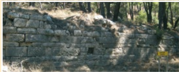
Fig. 88. Restos del muro de un Heroon en Phaselis. Aunque con predominio de sogas, contiene intercalados algunos tizones. En este caso, la secuencia es una hilada a soga y tizón por una de sillares acostados, repitiéndose hasta cuatro veces.
