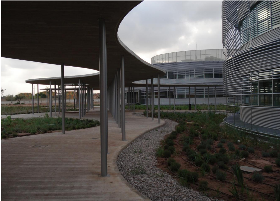
Vista de pérgola de unión entre edificios
