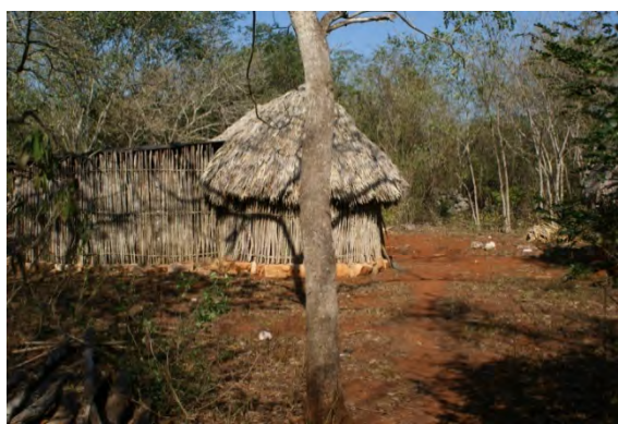
Fotografía 2. Vivienda de huano y bajareque en Pambijib, Tahdziu, Yucatán. (Pablo Quiroz Cantú)
