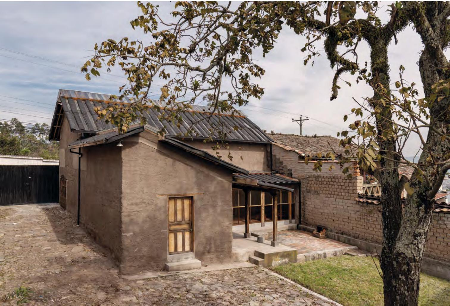
Los acabados de la obra terminada son casi los mismos que estaban ahí en mil ochocientos. Las operaciones de rehabilitación son muy pocas y muy estratégicas: se refuerzan estructuralmente los muros de tierra, se curan las paredes, se cambian las puertas y ventanas que estaban en mal estado y el piso se iguala con cemento.
