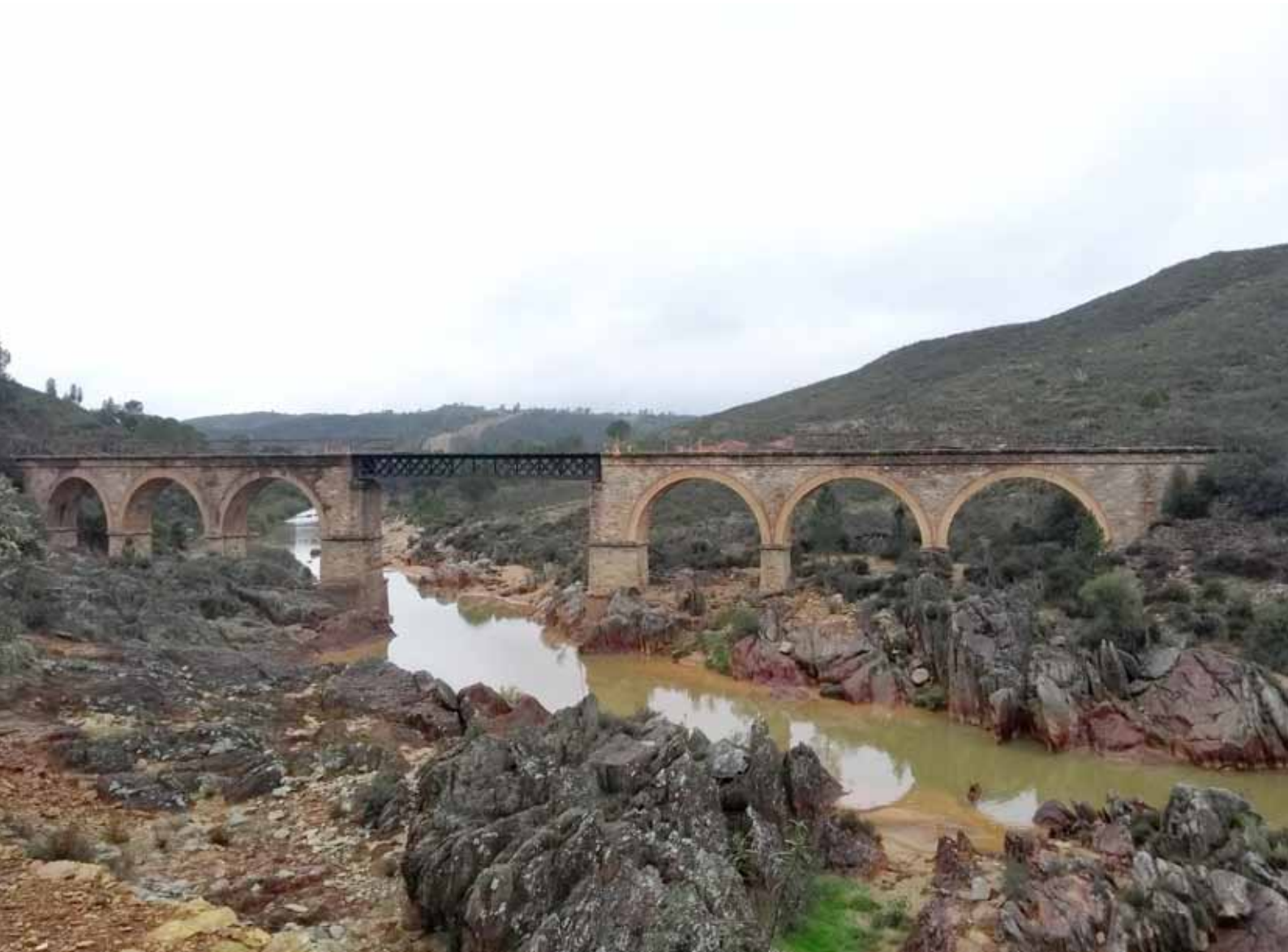
Puente sobre el río Odiel, ferrocarril de Concepción.
