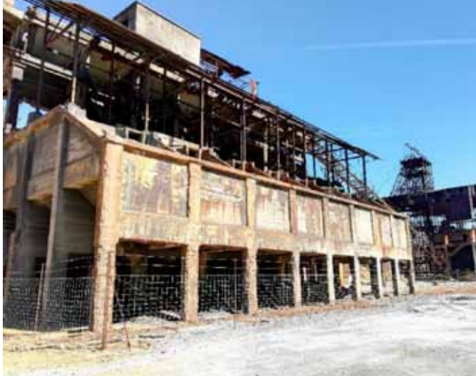
Pozo La Algaida y silo de triturado, almacenamiento y descarga de mineral del pozo nº 5 La Algaida.
