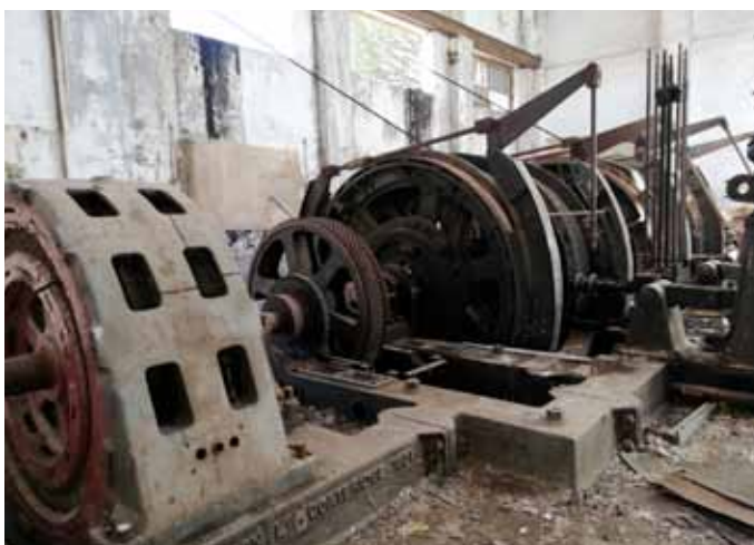
Interior casa máquina extracción.
