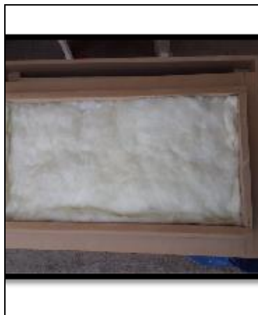
Figura 2 Aislamiento Térmico en paredes del modulo
