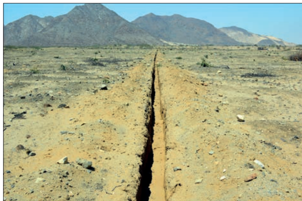
FIG. 11. Inicio de la construcción de infraestructura de riego en la pampa La Tendida, valle del río Zaña. Zona de importantes vestigios arqueológicos, escasamente registrados. Foto: Guadalupe Martínez.
