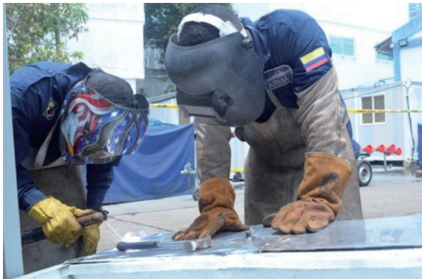
Fig. 5. Top lid welding.
