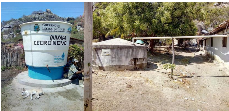
Figura 04: tipologia de captação e manejo de água de chuva nas comunidades Cedro Novo e Cedro Velho.
