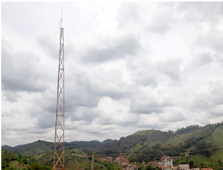
Foto 2 – Torre de transmissão da Rádio Paraíso
