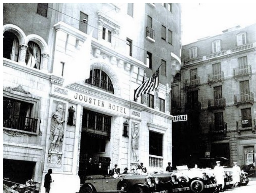
Figura 1: Fachada del Jousten Hotel
