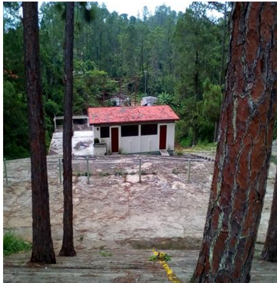
Figura 19. Casa- Redacción Escambray Fuente: Elaboración propia
