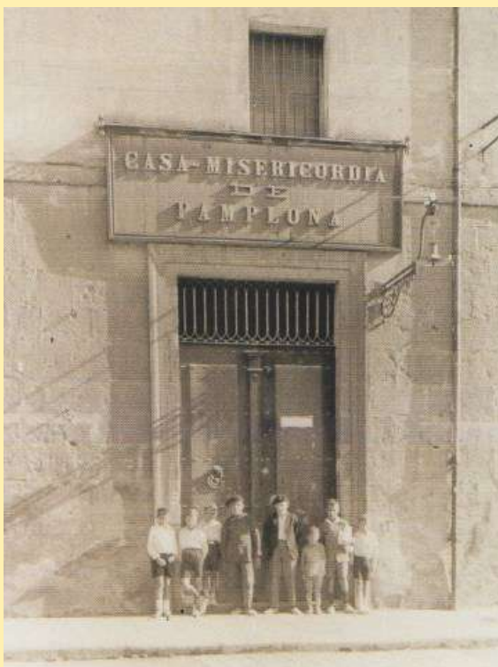
Local de la Casa de Misericordia en el Paseo de Valencia donde se instaló la primera Casa de Socorro municipal de Pamplona.
