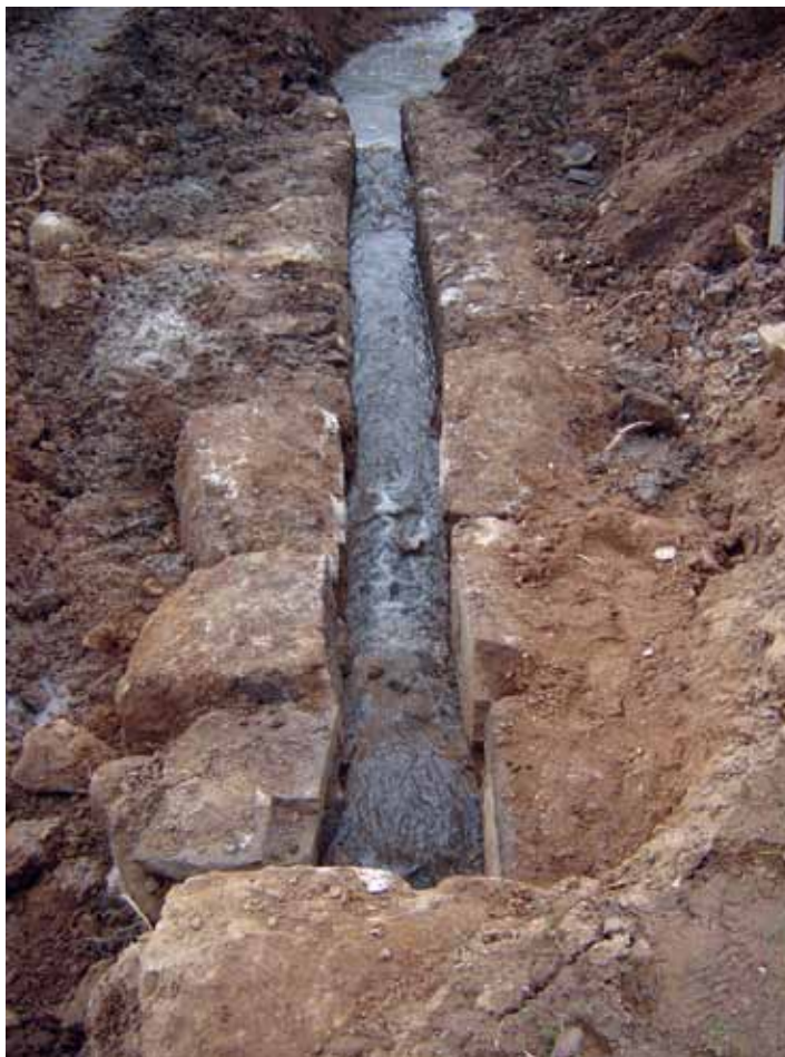
Fig. 8 – Estrutura 26 localizada na Estrada da Guerreira.
