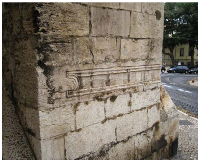
Fig. 15 Sofito reapregue num dos cunhais de contraforte (lado norte) da Sé de Lisboa. (Fotografia de Lídia Fernandes, Museu da Cidade).
