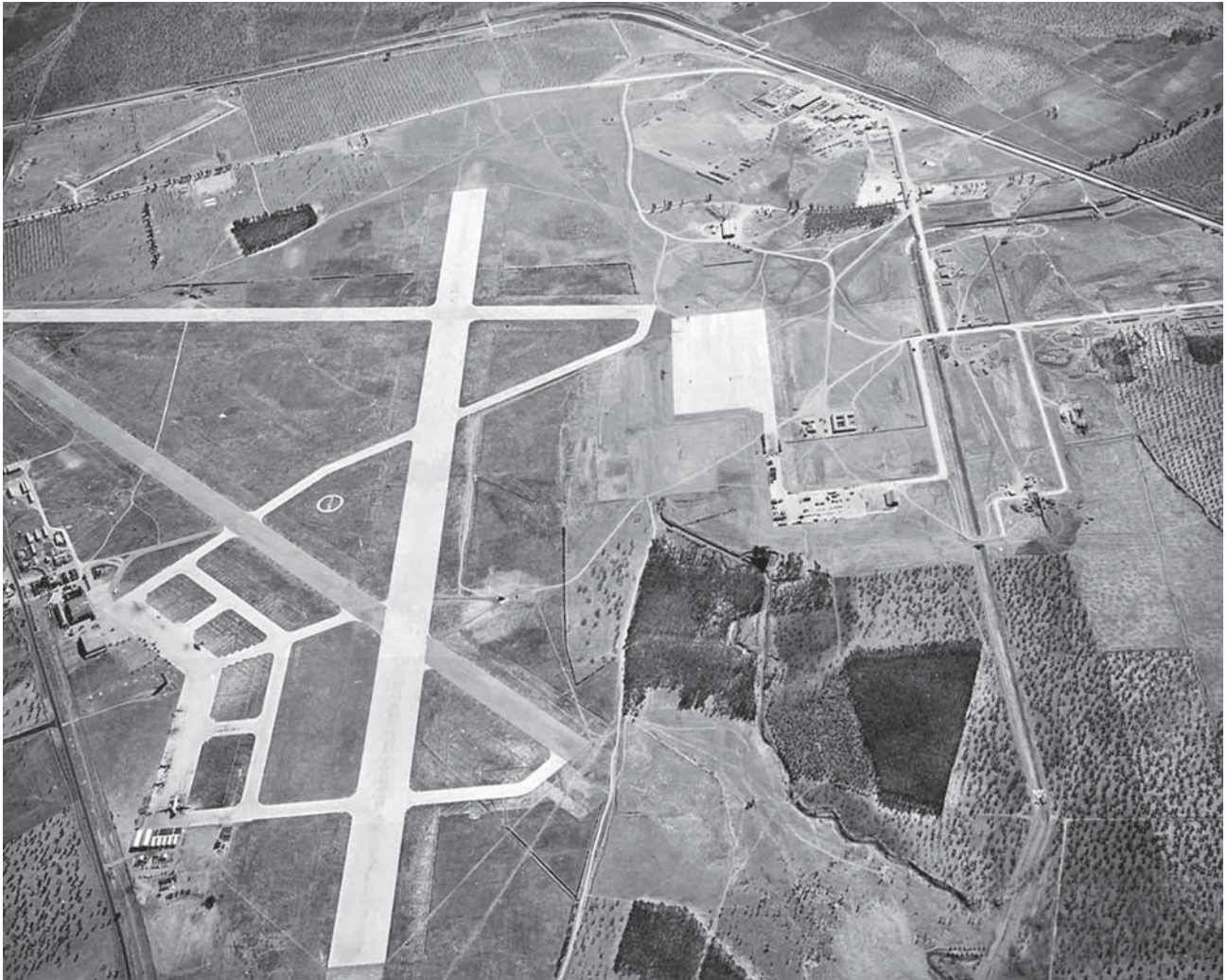
AEROPUERTO SEVILLANO DE SAN PABLO, SEPTIEMBRE DE 1957. A LA IZQUIERDA LA TERMINAL CIVIL, EN PRIMER TÉRMINO LA PISTA AMPLIADA POR LOS AMERICANOS, Y A LA DERECHA LAS INSTALACIONES MILITARES, QUE INCLUÍA UN HOSPITAL. FUENTE: FONDO DE LA UNIVERSIDAD DE ALCALÁ DE HENARES. HTTP://DSPACE.UAH.ES/DSPACE/HANDLE/10017/1430
