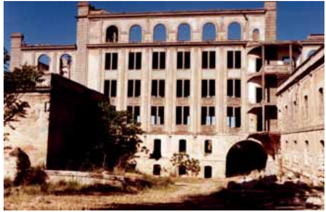
6. FOTOGRAFÍA GENERAL DEL LATERAL DE LA FÁBRICA (AMP, 2000).
