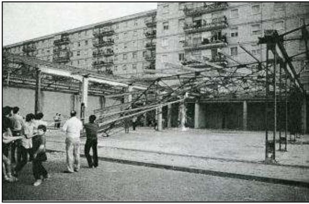
Tirando las naves industriales.
