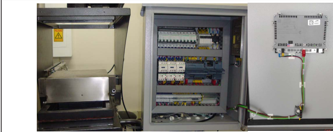
Figura 9. Circuitos eléctrico y de control máquina termoformadora
