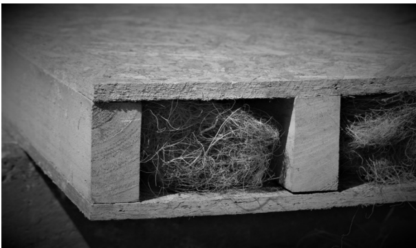
Figura 2. Fibra de coco en muro de madera. Fuente: Los Autores.
