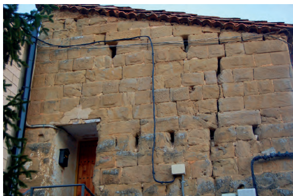
Fig. 24. Labata. Torre de A Carceleta, fachada occidental, mitad superior. Detalle del aparejo andalusí primitivo de módulo pequeño , con sillares a soga y sobre todo a tizón, con leve almohadillado alisado y listel perimetral asentados con finos tendeles de mortero de cal y con llagas muy próximas entre hiladas. Algunos bloques a tizón presentan formas de tendencia trapezoidal. Se aprecian también numerosas sogas de esquina en hiladas alternas.
