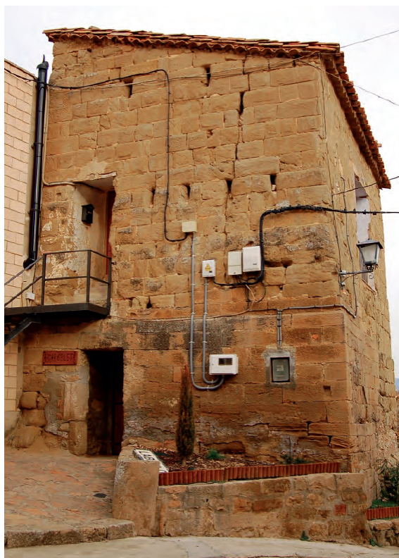
Fig. 22. Labata. Torre de A Carceleta, fachada occidental y esquina suroeste. Imagen de 2008 previa a la restauración de 2011. Obsérvese el aparejo andalusí primitivo de módulo pequeño en los 2/3 superiores de la misma, ya que la parte inferior fue modificada añadiendo un recubrimiento externo de bloques de arenisca a soga que oculta la fábrica primitiva. En esas fechas todavía se apreciaba el arranque de lo que podría ser un paño de muralla de dirección este-oeste en la esquina noroeste de la torre, a la izquierda de la imagen, eliminado en dicha restauración.
