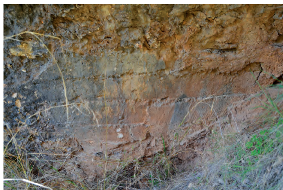
Fig. 29. Castillo de la cresta Marmañana. Detalle del intradós de la bóveda de cañón que cerraba el aljibe del reducto superior. Obsérvese el recubrimiento interno de mortero de cal que conserva las improntas de las tablas de madera del encofrado.
