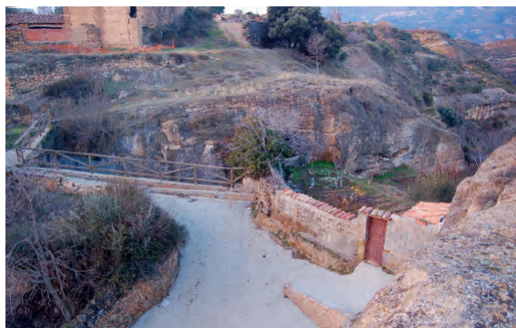
Fig. 20. Labata. Detalle del foso y del aljibe «Pozo Largo» al oeste-noroeste de La Mota. Imagen tomada desde la cumbre del reducto defensivo.
