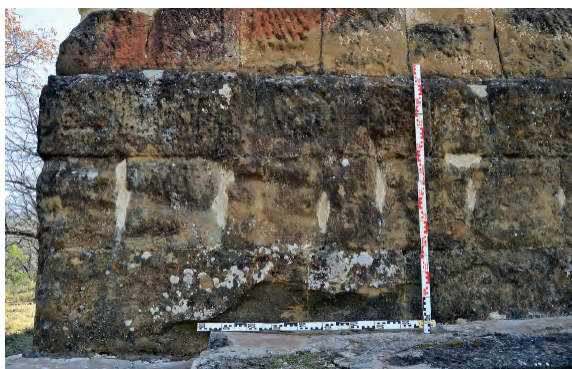
Fig. 11. Ermita de La Magdalena de Panzano. Muro norte y esquina noreste de la cabecera: detalle del aparejo original andalusí de sillares, con tizones, soga de esquina y alzado escalonado por medio de retranqueos en el muro.
