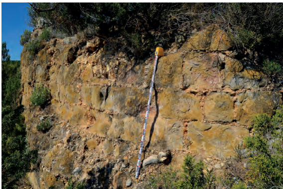
Fig. 32. Castillo de la cresta Marmañana. Detalle del aparejo del ábside semicircular de la iglesia románica, del que se conservan apenas cuatro hiladas, construido sobre potente basamento. Obsérvese, a la izquierda de la imagen, el ángulo del presbiterio que separaba la cabecera respecto a la nave del templo y el aparejo de sillarejo de arenisca en hiladas seudoisódomas con gruesos tendeles de un mortero de cal con abundante arena y gravilla.
