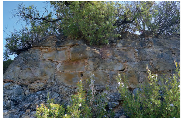
Fig. 33. Castillo de la cresta Marmañana. Detalle de lo que queda del muro de los pies de la iglesia románica, construido con sillarejo seudoisódomo sobre la roca natural de conglomerado, con ayuda de ripios de piedra y fragmentos de teja.
