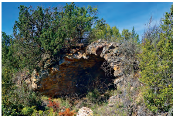
Fig. 28. Castillo de la cresta Marmañana. Detalle del aljibe de la parte superior del reducto defensivo. Bóveda de cañón construida con lajas a sardinel con ayuda de un encofrado.
