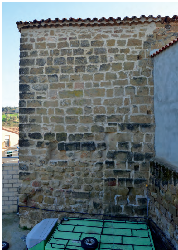
Fig. 23. Labata. Torre de A Carceleta, fachada norte. Obsérvese la primitiva esquina noreste de la torre, en el centro de la parte inferior de la imagen, y lo que queda de la fábrica primitiva andalusí, conservada hasta la altura de la cubierta en el extremo occidental, a la derecha de la fotografía. Como se aprecia, la torre fue ampliada por el este, eliminando el muro oriental y añadiendo un nuevo cuerpo se mampostería y sillares reutilizados, cuyo interfacial con respecto al aparejo original se percibe claramente.
