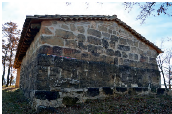
Fig. 7. Ermita de La Magdalena de Panzano desde el noreste. Cabecera del templo en la que se aprecia el aparejo de sillares de gran módulo perteneciente a la torre defensiva andalusí.
