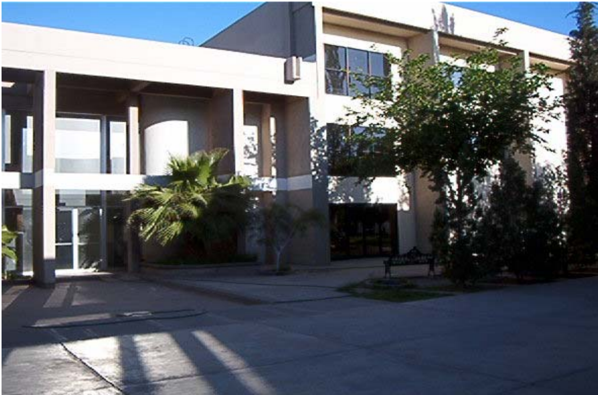
Centro de Cómputo. Instituto de Ingeniería y Tecnología. UACJ.
