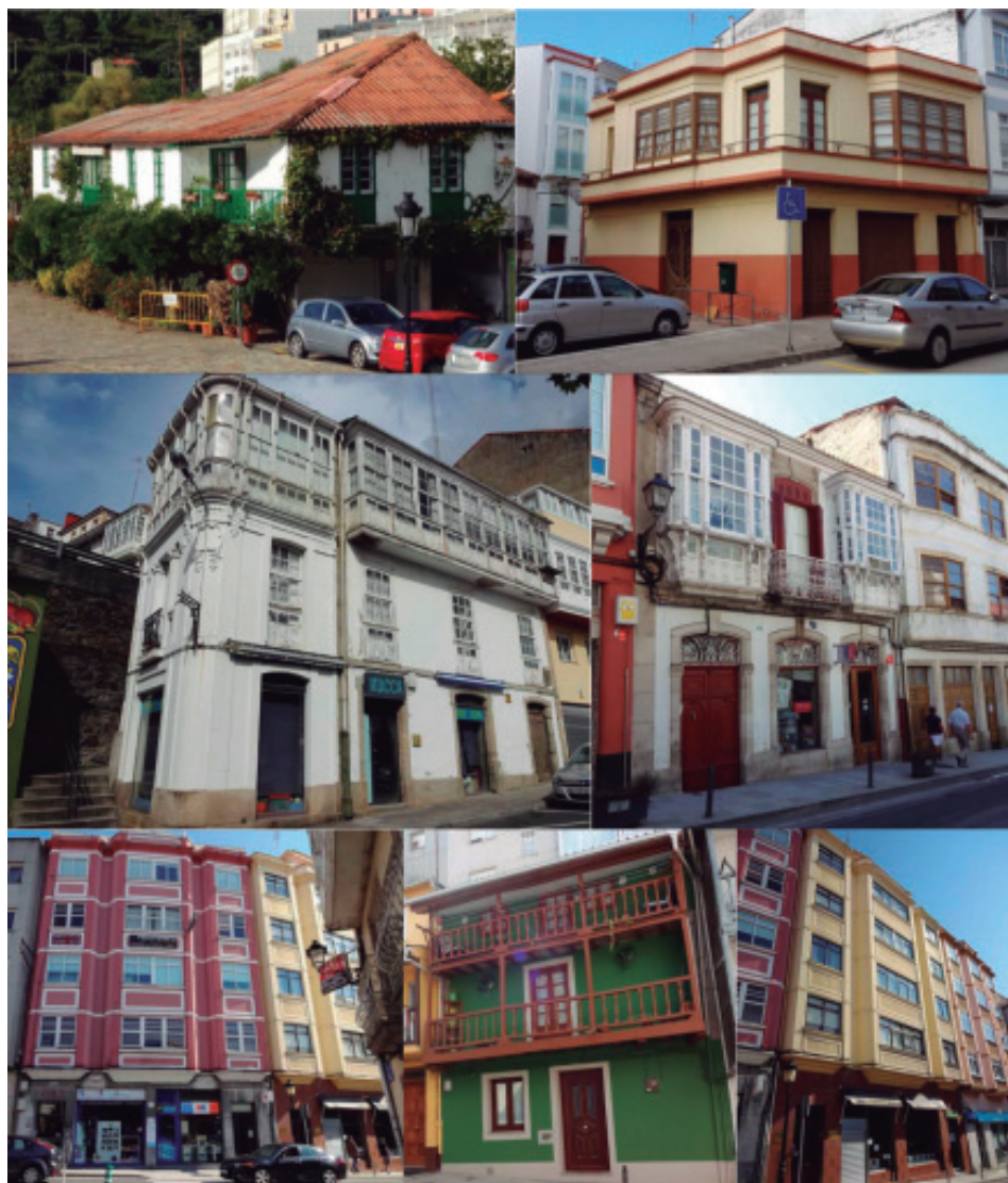
Fig. 22. Exemplos de inmobles susceptibles de seren catalogados (de arriba a abaixo e de esquerda a dereita: nº 1 da Praza Henrique IV, nº 41 da Rúa da Ribeira, nº 13 da Rúa do Valdoncel, nº 12 da Avenida Linares Rivas, nº 5 da Avenida Jesús García Naveira, nº 37 da Rúa da Cruz Verde e nº 7-9 da Avenida. Jesús García Naveira). Catastro.
