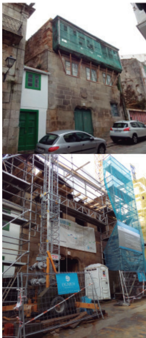
Fig. 20. Edificio da Rúa da Cerca antes e durante a restauración. Catastro e elaboración propia.
