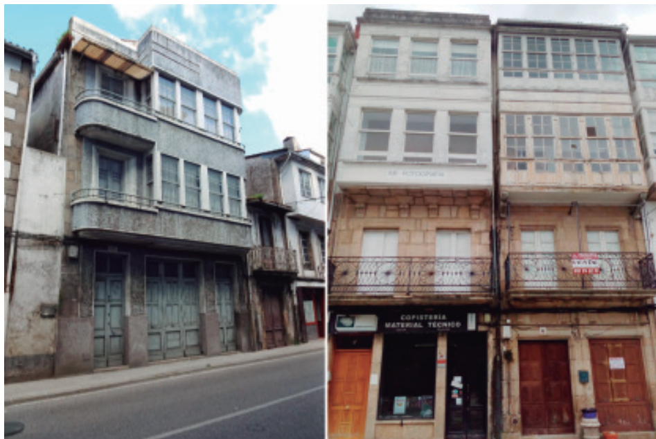
(Esquerda) Exemplo da nova arquitectura racionalista de Leoncio Bescansa na Rúa do Alfolí. (Dereita) Imaxe comparativa da galería tradicional de madeira fronte ás novas propostas en formigón dos anos 30. Fotos do autor.
