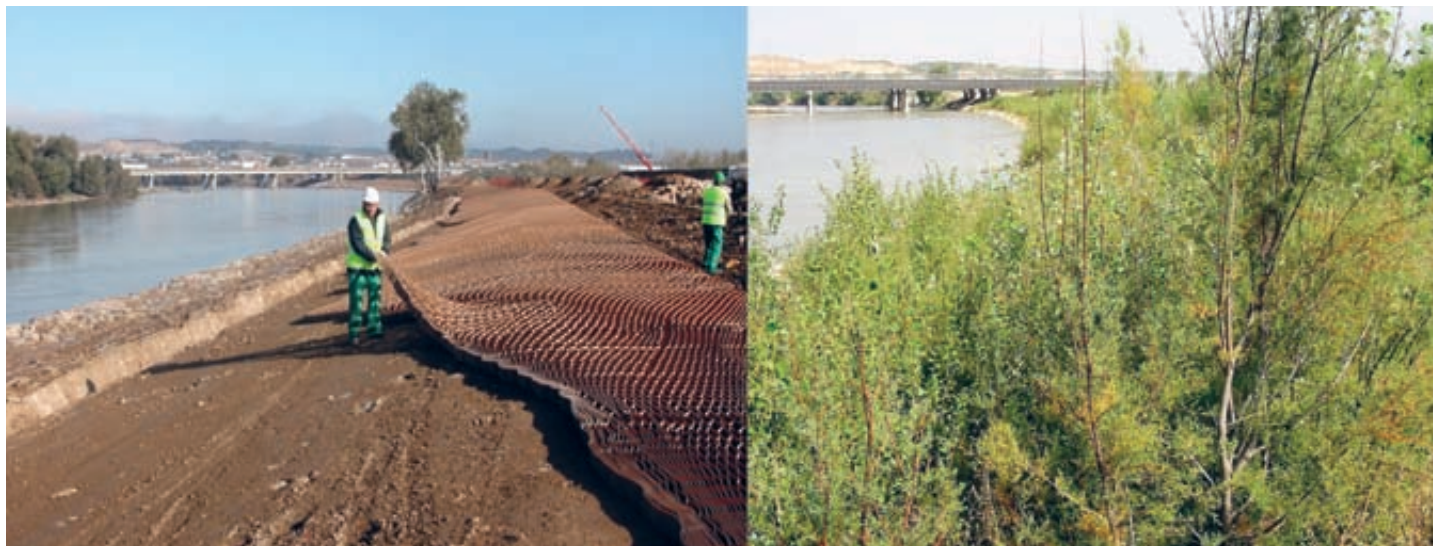
[Fig.9]. Construcción de la defensa del Parque del Agua. 2006, y soto del Parque del Agua. 2009. Fuente: Autor.
