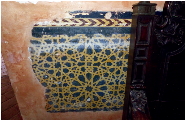
5. CASA DE LOS PINELO. ANTIGUA CÁMARA, HOY NAVE DE LA CAPILLA. MURO NORTE. RESTITUCIÓN PICTÓRICA DE LOS AZULEJOS DESAPARECIDOS. SIGLO XIX.
