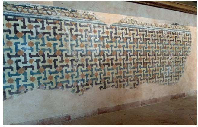
6. CASA DE LOS PINELO. ANTIGUA CÁMARA HOY NAVE DE LA CAPILLA. MURO OESTE. SUSTITUCIÓN PICTÓRICA DE LOS AZULEJOS DESAPARECIDOS. SIGLO XIX.
