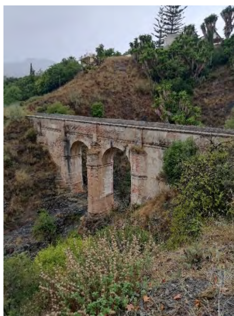
Figura 8. Puente sobre el arroyo Hondo.
