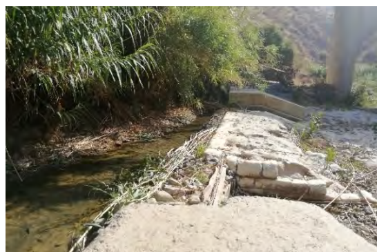
Figura 4. Detalle del azud de la toma de agua del acueducto.
