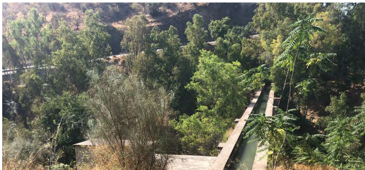
Figura 1. Tramo sobre el arroyo Humaina del acueducto de San Telmo.
